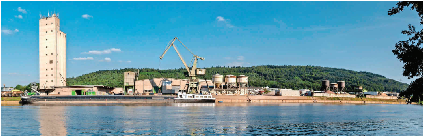
Ein Frachtschiff beim Entladen, dem sogenannten »Lösch« seiner Ladung an der 300 Meter langen Kaimauer des Mainhafens.
