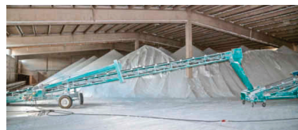
Auf 5000 Quadratmeter Fläche können Rohstoffe in Hallen gelagert werden.
